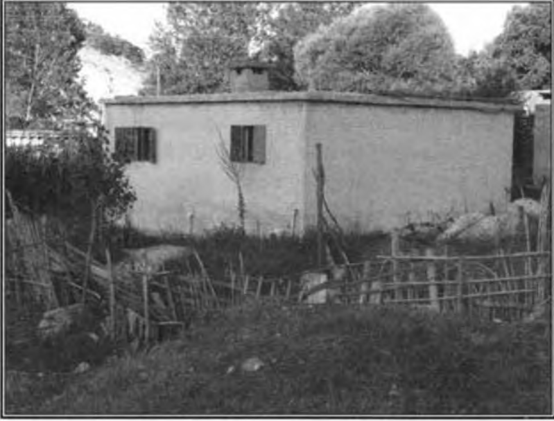
Fotoğraf 3.66. Karçukuru yaylasında düz damlı ve çatı örtü malzemesi olarak toprak kullanılan konutlar çoğunluğu oluşturur.
