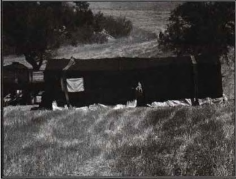
Fotoğraf 2.7. Yazır Beydağı yaylasında alaçık adı verilen çadır yayla konutu. Bu çadır konutlar genellikle altı veya sekiz ana direk üzerine inşa edilmişlerdir. İskeletin üzeri keçi kılından yapılmış çul ile örtülüdür. Çadırların içi genellikle iki bölmeden oluşmaktadır.
