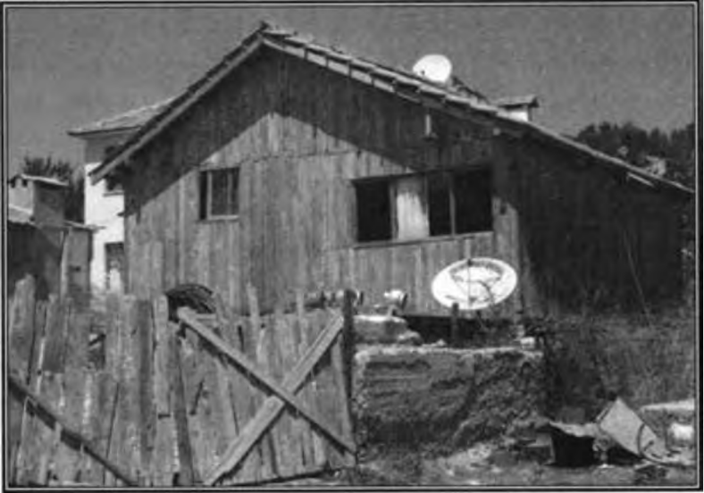
Fotoğraf 2.5. Beydağlarında devamlı yayla konutlarının bir bölümü yakın çevreden temin edilen yapı malzemeleri ile inşa edilmiştir. Yaylalarda sedir ve ardıç ağaçları konut yapı malzemesi olarak sıkça kullanılmaktadır.
