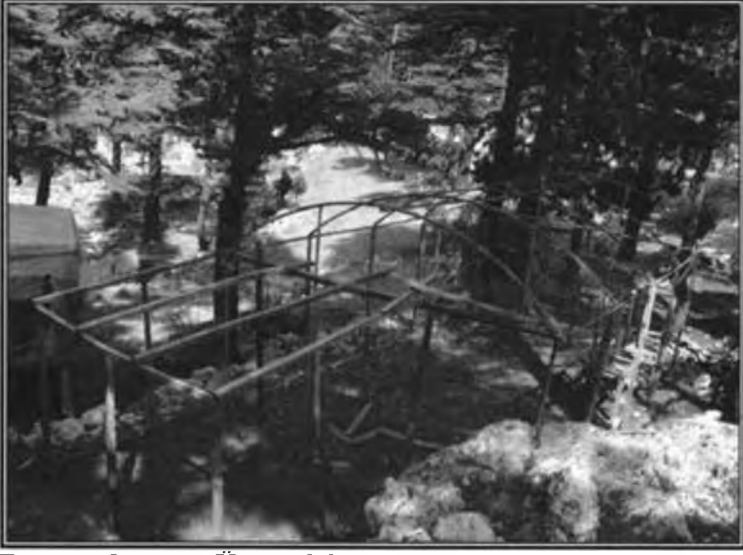
Fotoğraf 3.104. Üzerindeki naylon veya hasır örtü sökülerek gelecek yayla dönemine kadar terk edilen bir yurt iskeletinden görünüm.
