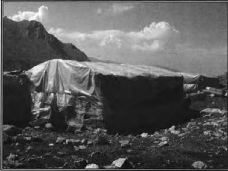
Fotoğraf 3.32. Kartal Yaylası'nda iskeleti ardıç ağacı, üzeri ise karton ve naylon ile kaplanmış bir çadırdan görünüm. Yaylacılar çadırın gövdesini oluşturan ana yapıya “ceset” adını vermişlerdir.
