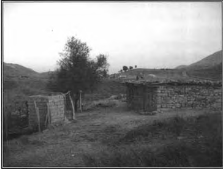
Fotoğraf 3.73. Beydağı yaylasında geleneksel tarzda bir yayla konutunun görünümü. Konut yapı malzemeleri büyük çoğunlukla yakın çevreden sağlanmıştır.
