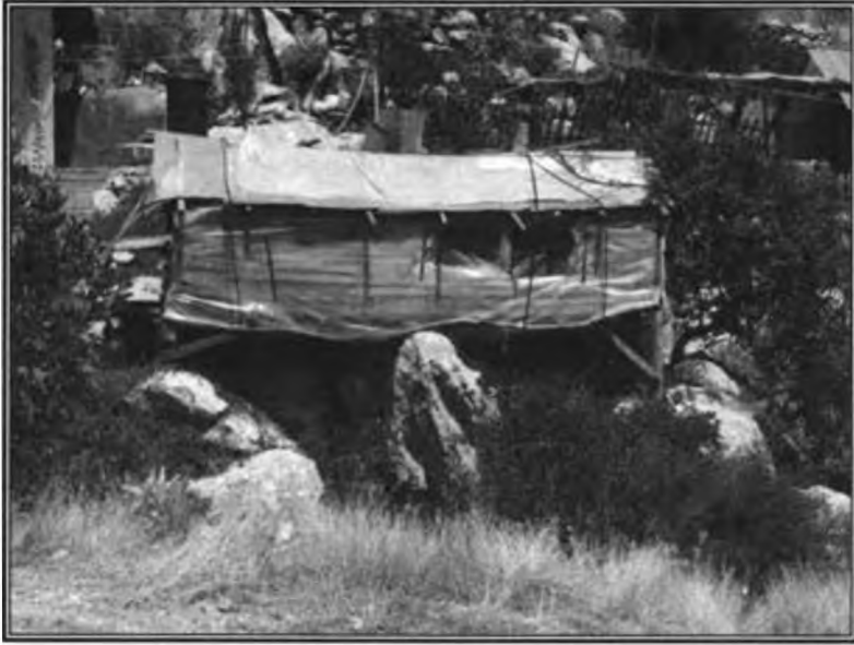
Fotoğraf 3.109. Karagöl yaylasında ahşap malzeme kullanılarak inşa edilen bir yayla konutu. Konutun inşasında çevredeki kayalardan temel olarak faydalanılmıştır.
