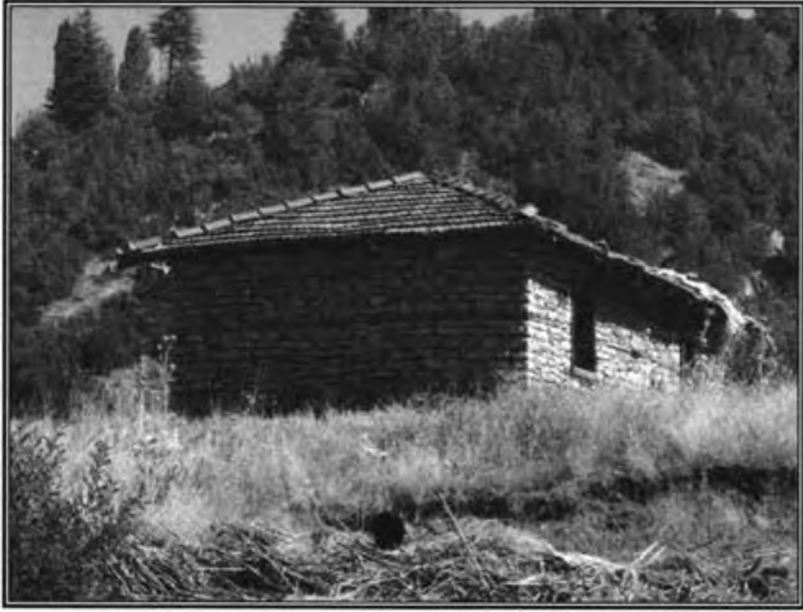
Fotoğraf 3.44. Sinandegirmeni yaylasında taş duvarlı eski bir yayla konutundan görünüm. Toprak çatı örtüsünün yerini zamanla kiremit almıştır.
