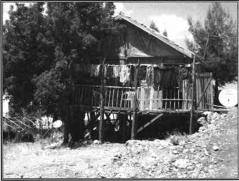
Fotoğraf 3.82. Göllü yaylasında ahşap malzeme ile inşa edilmiş konut sayısı giderek azalmakta, yeni konutlar köylerdeki yapı tarzını yansıtmaktadır.
