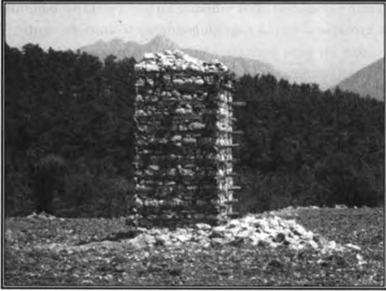
Fotoğraf 3.17. Yazır yaylasında kısa bir süre öncesine kadar kullanılan bal serenleri oldukça dikkat çekici bir yapı tarzına sahiptir. Ardıç ağacından elde edilen tahtaların arasına taşların yerleştirilmesi ile inşa edilmişlerdir. Kovanların depolanması amacıyla kullanılırlar.
